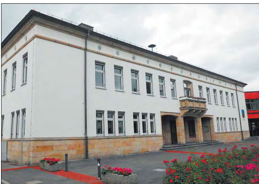
Das Rathaus Bad Driburg trägt die Handschrift der Firma Amstutz. Das Team hat es im Sommer 2010 von außen saniert.
