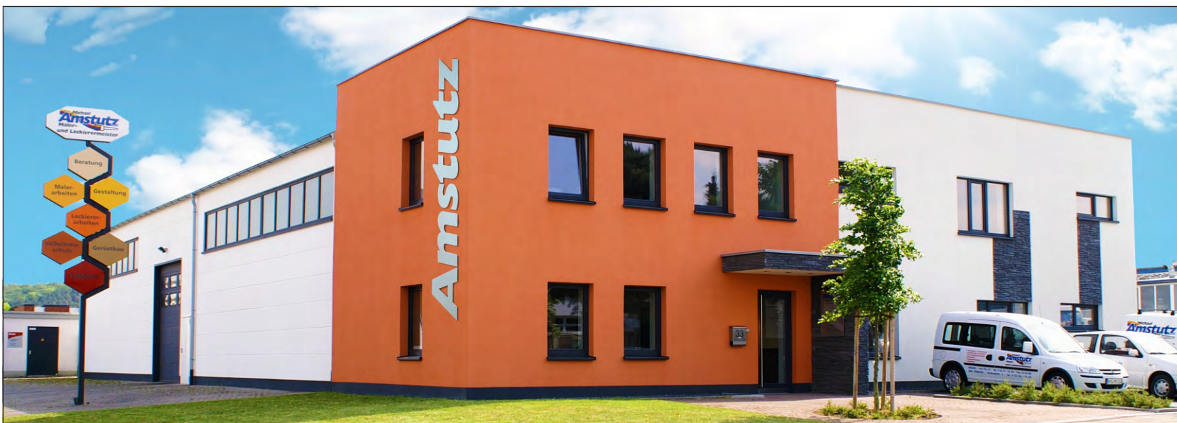
Der Unternehmenssitz der Firma Amstutz im Brakeler Industriegebiet. Die ansprechende Gestaltung fällt Vorbeifahrenden gleich ins Auge. Vom Ausstellungsraum bis hin zum Lager hat der renommierte Fachbetrieb am neuen Standort alles unter einem Dach.
