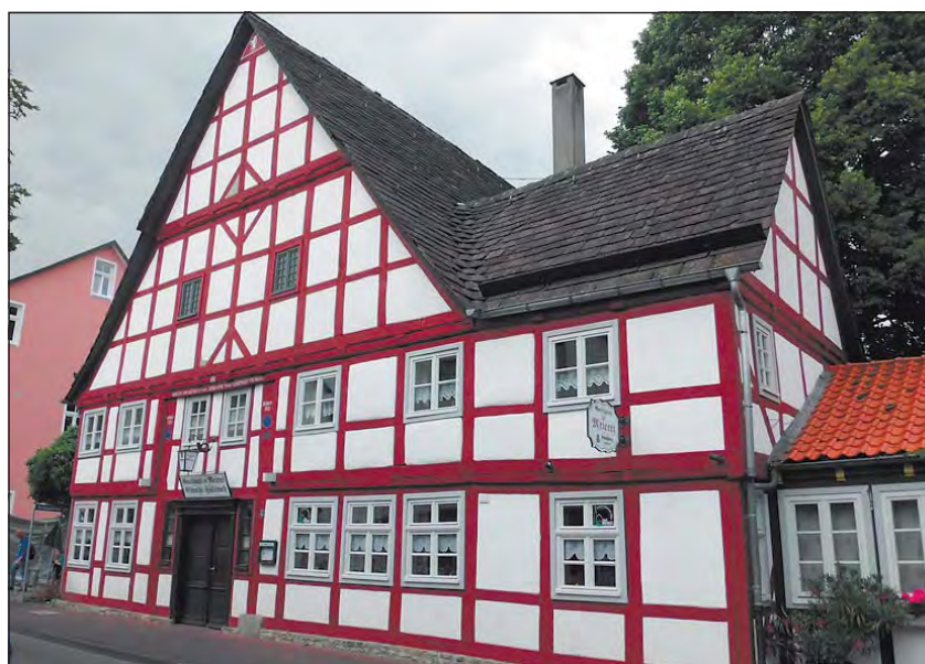
Die Fachwerksanierung ist eines der Spezialgebiete der Firma Amstutz. Die Meierei in Brakel ist ein gelungenes Beispiel.
